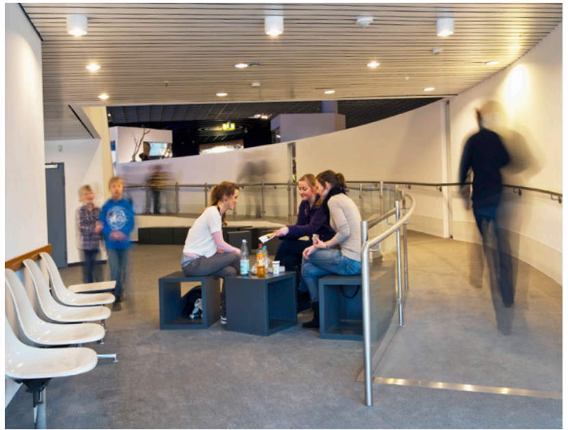
↑ LWL-Museum für Naturkunde in Münster: Einbau einer Rampe zur barrierefreien Erschließung der WC- und Wartebereiche
