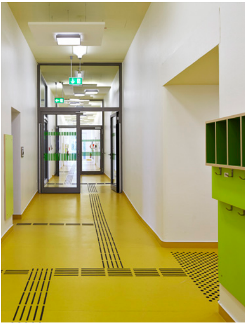
↑ LWL-Förderschule Paderborn: Kontrastreich gestalteter Flur mit Blindenleitsystem und guter Ausleuchtung
